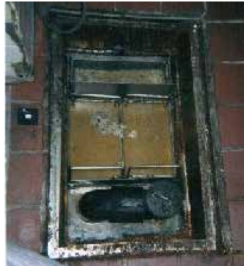
写真【B】 設置 2 週間後 (2 月 3 日) グリスト槽
